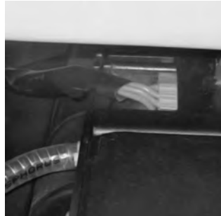
8 Kabel in die Durchführung einlegen.
