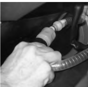
14 Establecer una toma de agua.
