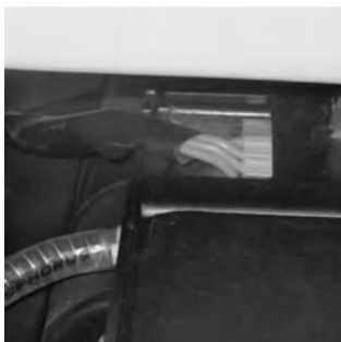
8 Legg kabelen i gjennomføringen.
