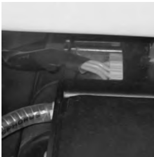
8 Włożyć kabel do przepustu izolowanego.
