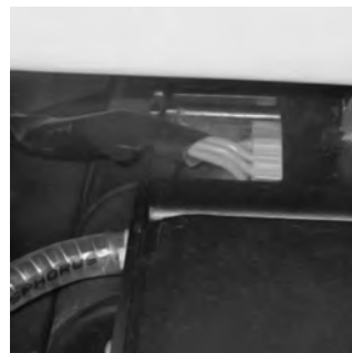
8 Postavite kabl u kanal.
