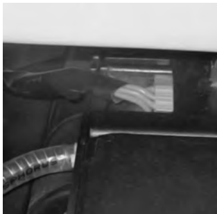
8 Læg kablet ind i gennemføringen.
