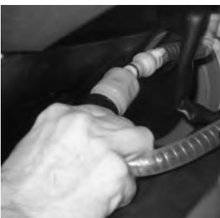
14 Vzpostavite vodni priključek.
