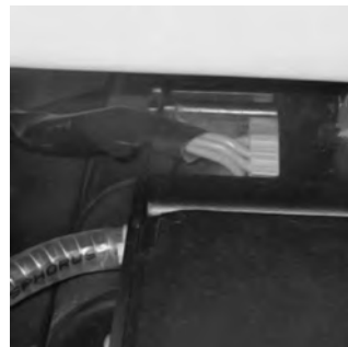
8 Kabel in de doorvoer leggen.
